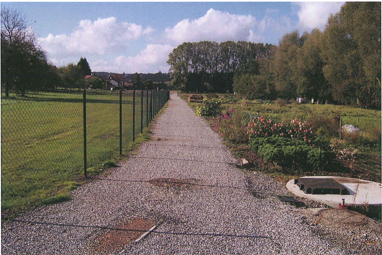
Pose de l'assainissement, empierrage et gravillonnage
