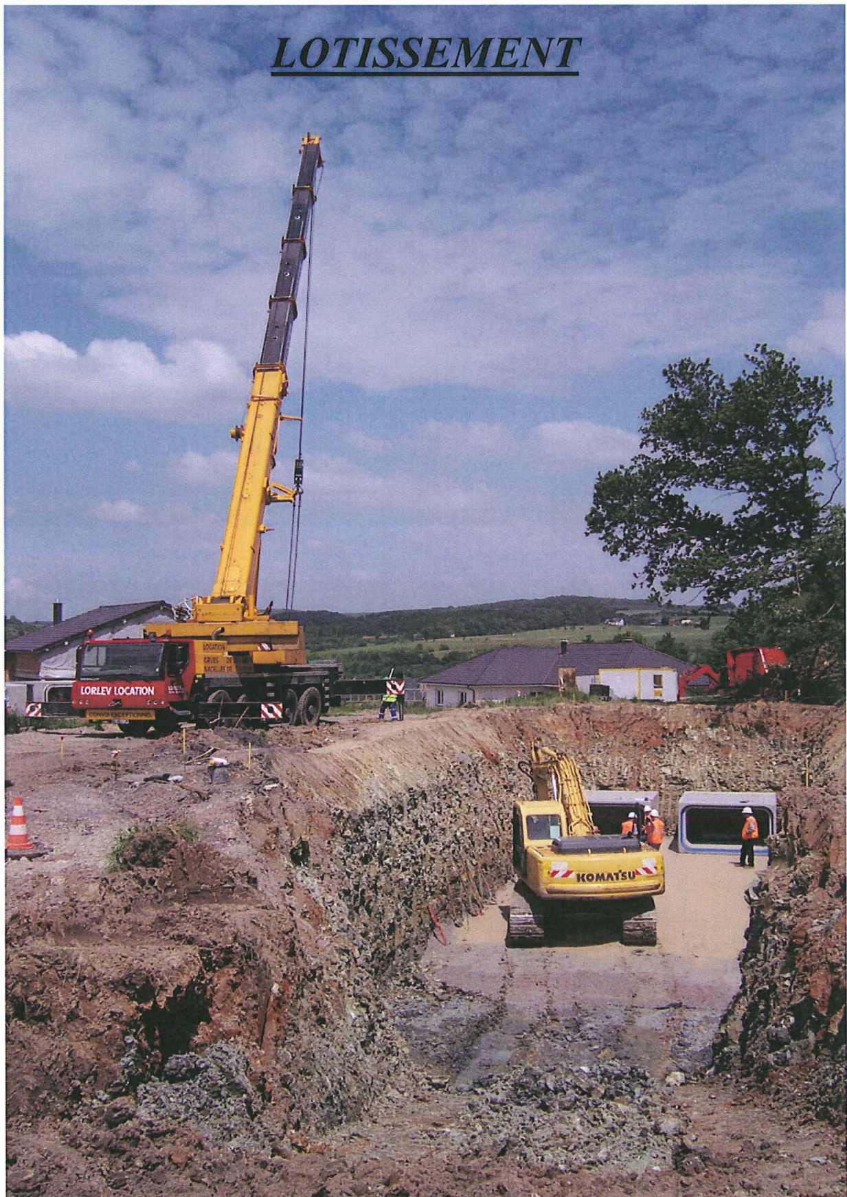
Mise en place du bassin de rétention, d'une capacité de 150 m 3
