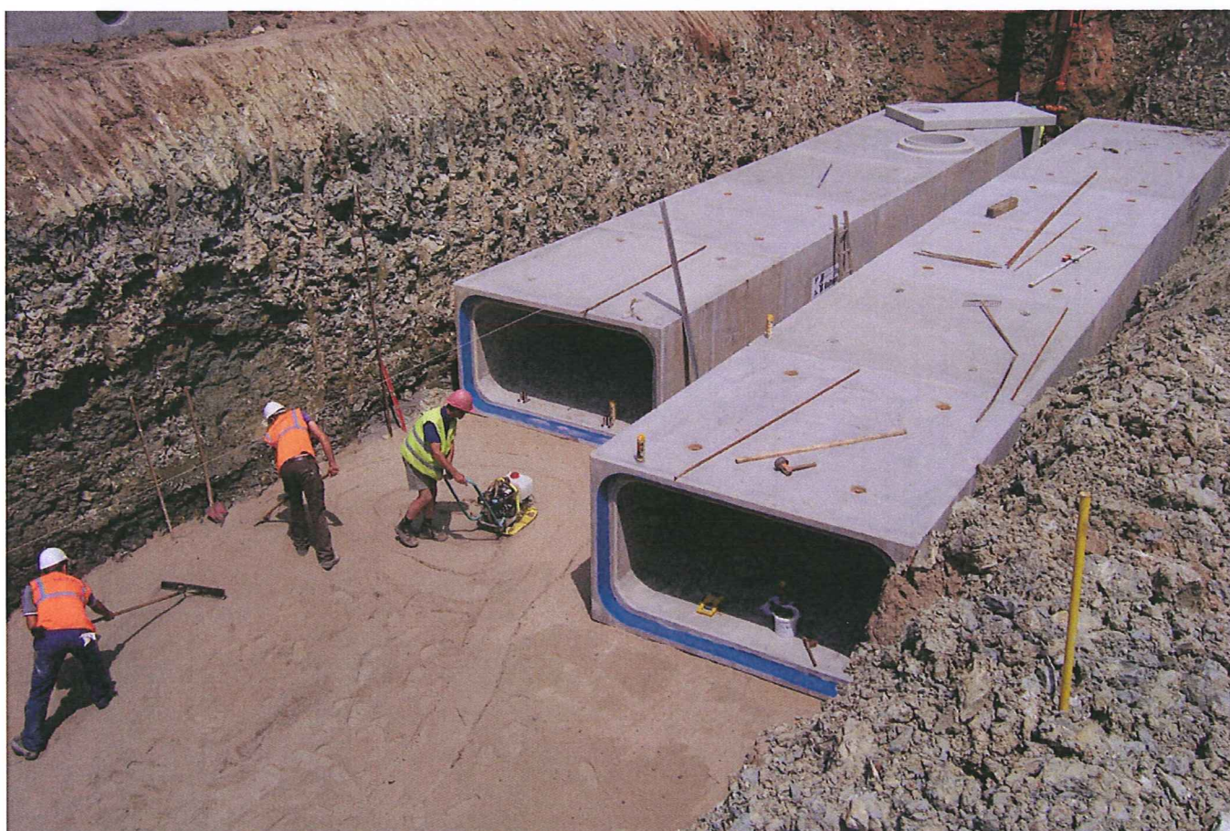
Bassin de rétention
